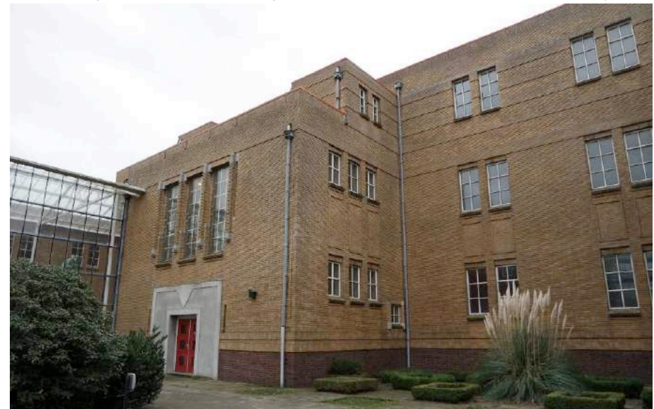
Achtergevel met links de drie glas in lood vensters van het centrale trappenhuis
