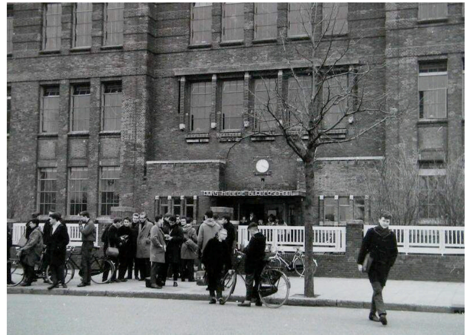
Entree in 1960. De letters prijken nog op de luifel en de kozijnen zijn nog niet vervangen (ZB Planbureau en Bibliotheek van Zeeland)
