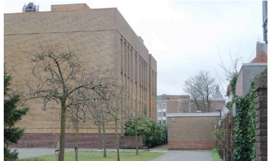
Blinde kopgevel van de linker vleugel, met rechts restant van schoolplein muurtje
