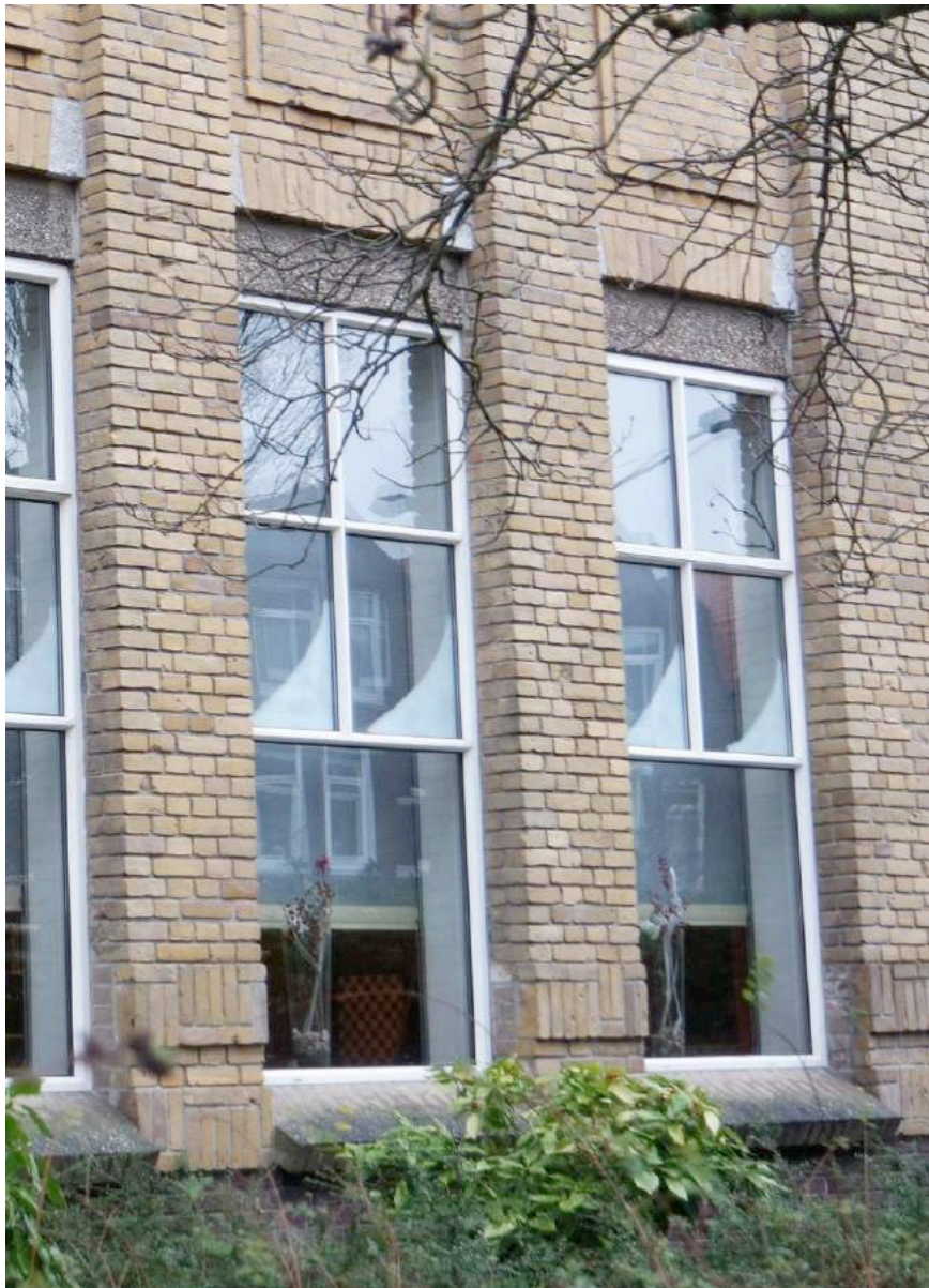
Doorgetrokken vensters rechter zijvleugel, met betonnen balk bovenin de vensters uit 1967 en recente kunststof kozijnen.
