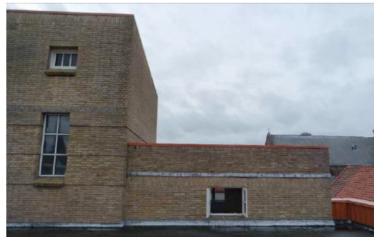
Rechts de dakopbouw op een voormalig dakterras met oranje afdekking van staalplaat
