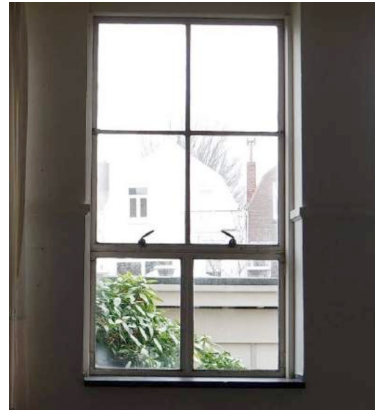
Kozijnen uit 1967, met hardstenen vensterbank, en lijstwerk langs de wanden
