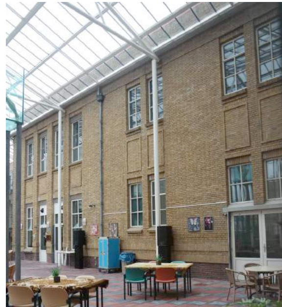
Overdekte binnenplaats met de aanpassingen aan de zijgevel van de rechtervleugel
