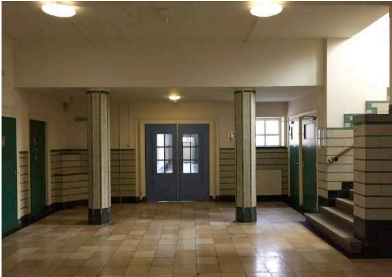
Centrale hal met verlaagd plafond steunend op kolommen. Links achter een fonteintje in de hoek
