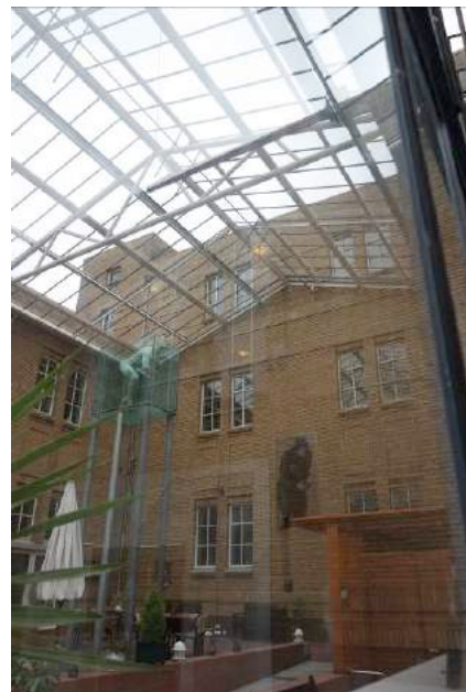
Achtergevel onder latere overkapping
